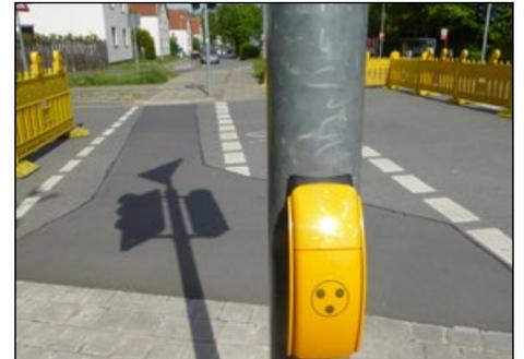
Unterhalb des gelben Schalters ist ein Taster zur Auslösung des Tonsignals.
