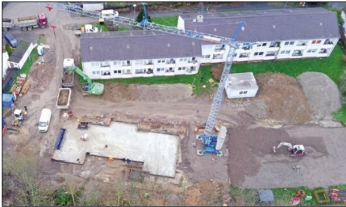
Die Baustelle aus der Vogelperspektive. Oben ist die Wohnanlage Lübecker Straße 10, darunter wurde die Bodenplatte für die neuen Gebäude gegossen
